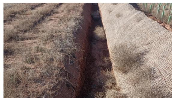
**Implantación de malla de coco para la prevención de la erosión en la Planta Fotovoltaica "Valdenebro Solar", Muniesa (Teruel)**
