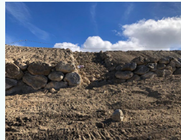
Disipador de energía
