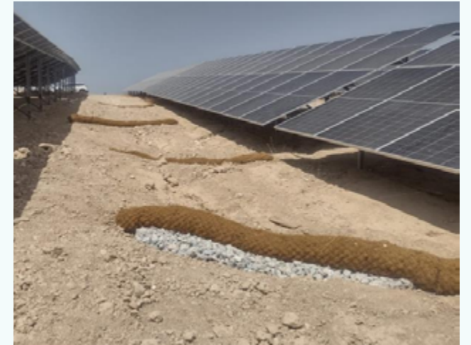
Biorrollos con gaviones flexibles
